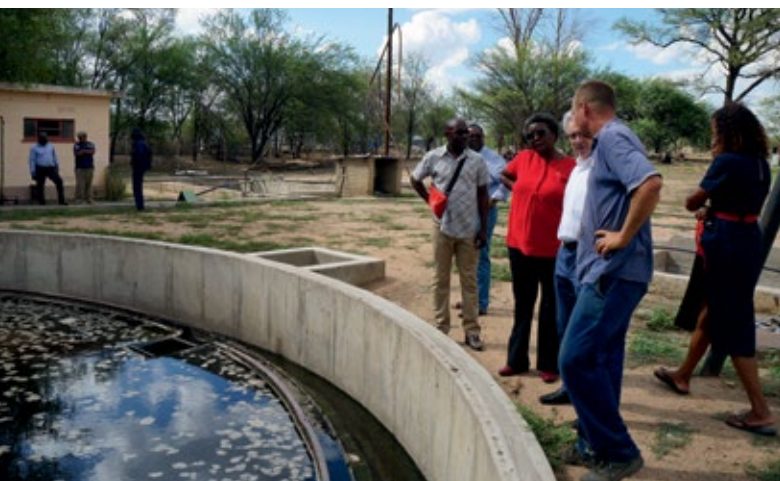
Des actrices et acteurs de Okahandja montrent à leurs partenaires de Schwäbisch Hall la station d'épuration de Okahandja © Ville de Schwäbisch Hall
